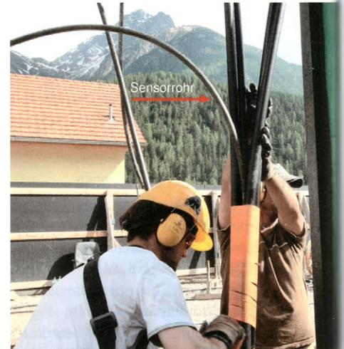
Zuerst wurden die Erdwärmesonden erstellt und bei drei der 20 Sonden Temperaturmessfühler in die Hinterfüllung eingebracht. (Bild: Vassella Energie GmbH)
