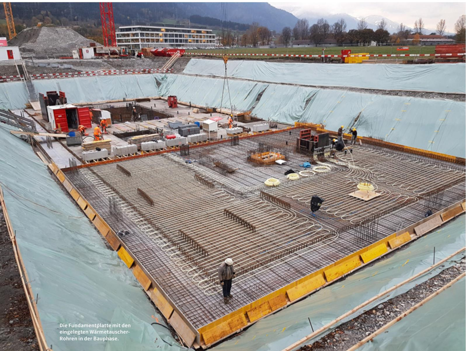
Die Fundamentplatte mit den eingelegten Wärmetauscher-Rohren in der Bauphase.
