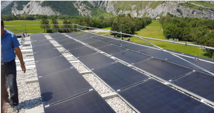
Die doppelt verglasten PVT-Module produzieren Strom und Wärme. Sie werden aber auch eingesetzt, um das Gebäude zu kühlen. Das PVT-System ist auf den Kühlfall optimiert. Wäre das System auf den Wärmeertrag optimiert, könnte etwa 20-mal mehr Wärme gewonnen werden.
